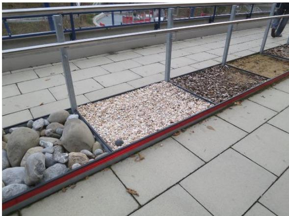
An den scharfen Metallkanten wurde ein Kantenschutz und eine rote Markierung angebracht (Auditbericht 2015 / Punkt 07).
