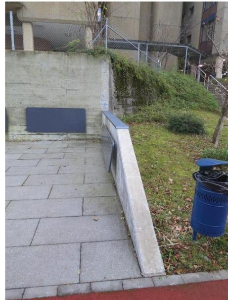
Die Absturzstelle auf der Mauer wurde eliminiert, indem die Mauer oberhalb 1m entfernt wurde (Auditbericht 2015 / Punkt 06).
