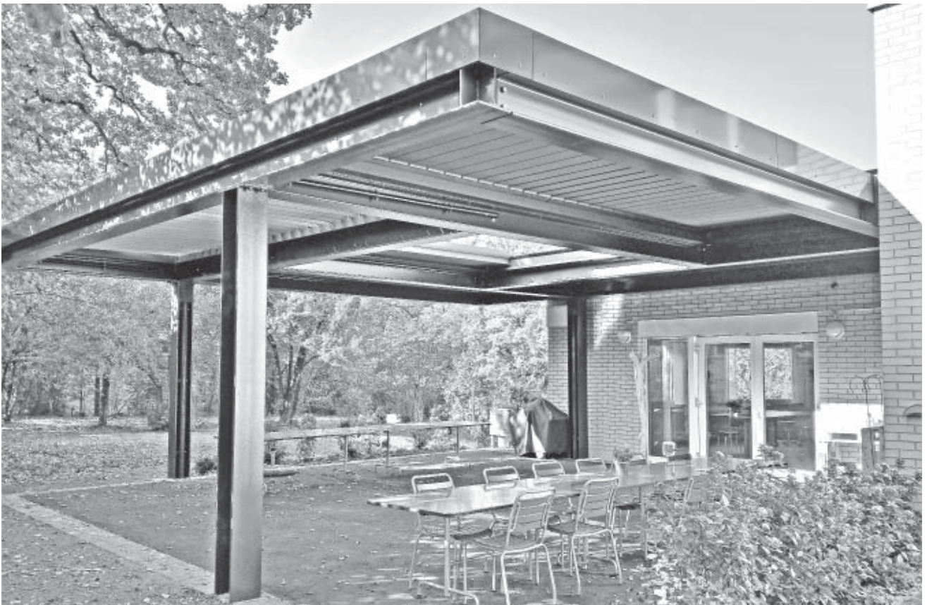
Der Metallbau-Pavillon mit verstellbaren Lamellen im Dachbereich und einer verschliessbaren Öffnung in der Mitte bietet genügend Platz für schöne Grillfeste.
