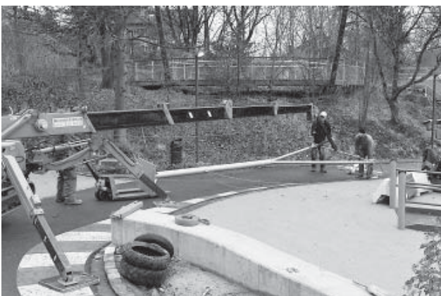
Den Dreizeitenpendel aufzustellen gibt viel zu tun.
